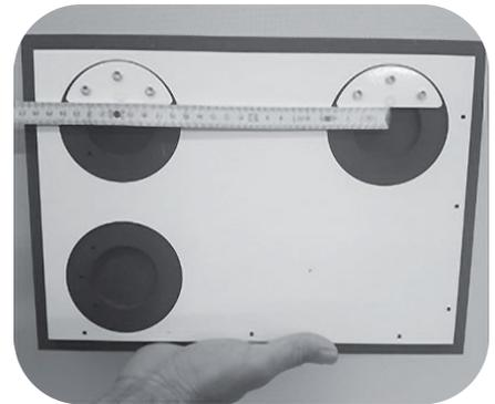
2. Nivellierung mit Hilfe des Exzenters. Wandtafel einhängen und überprüfen, dass die Tafel richtig eingehängt und befestigt ist.
